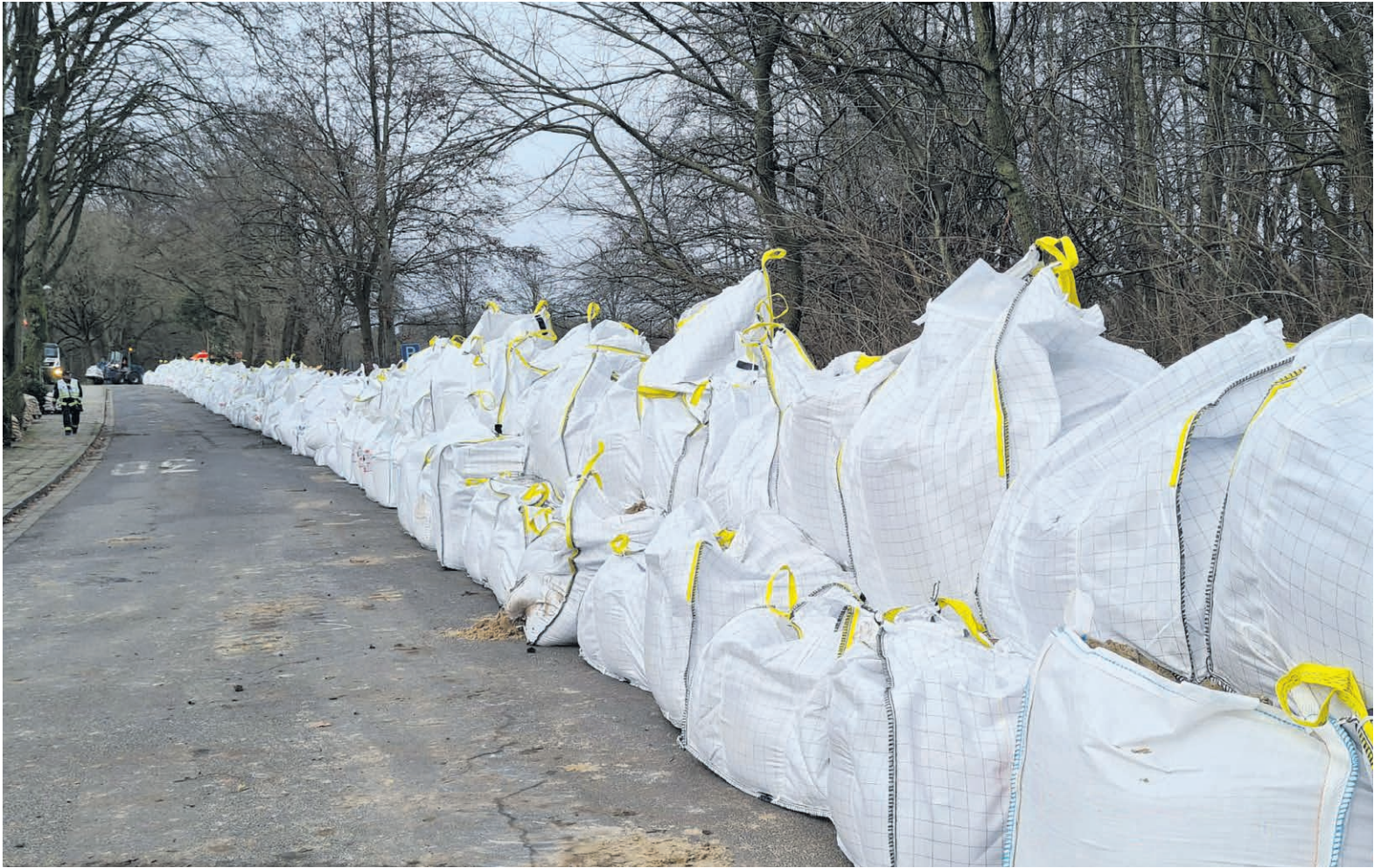
Deichverteidigung mit Bigpacks in Meppen Esterfeld im Dezember 2023
